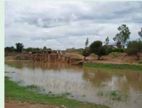
Koulikoro: Das Ufer des Niger wird durch den Abbau von Sanden instabil.
